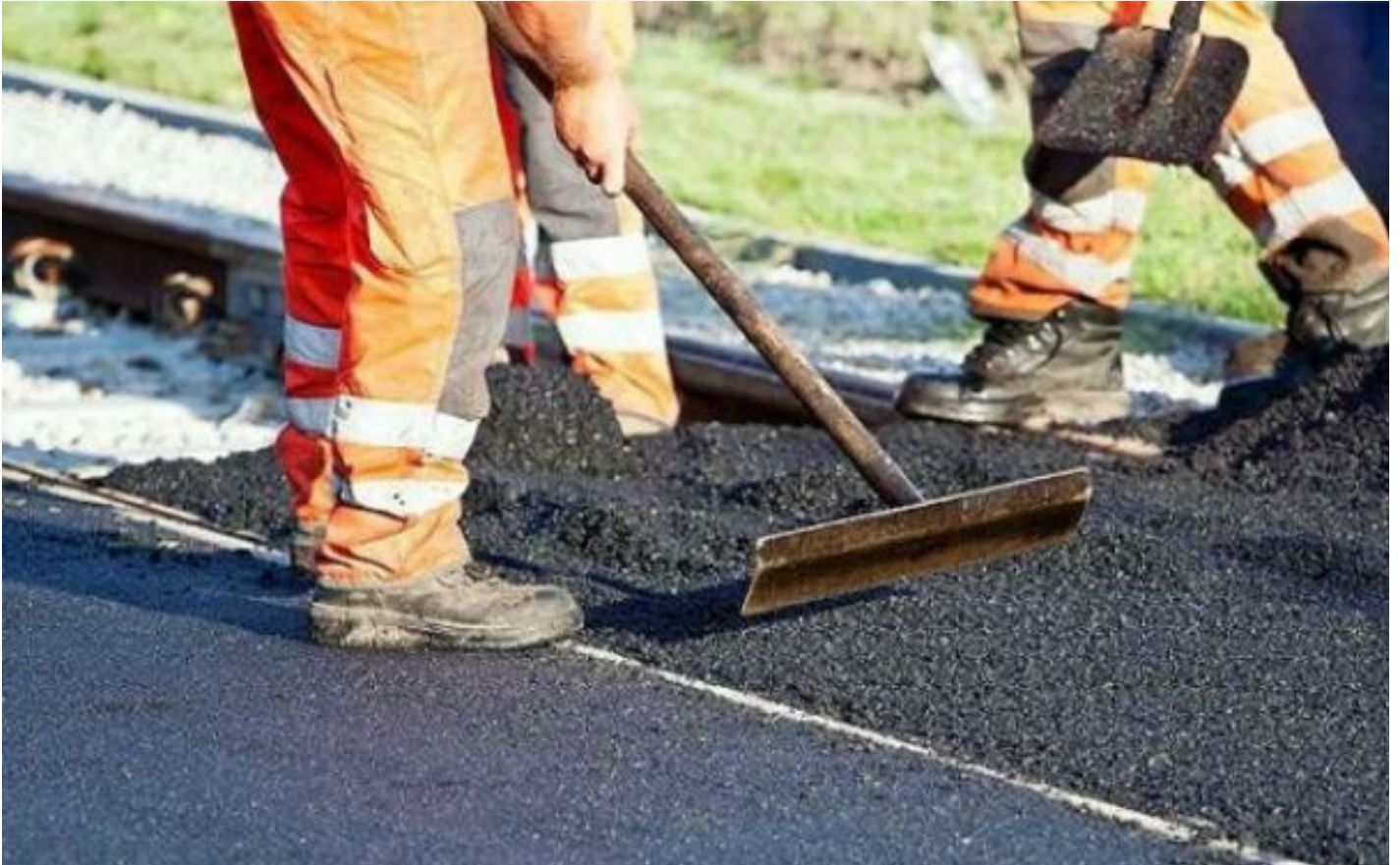
Descriere foto: asfaltare
